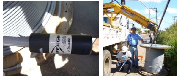
Figura 13: À esquerda, pode-se visualizar a mufla isolante corretamente aplicada ao terminal do cabo que permanece na bobina, no solo. À direita, pode-se visualizar a bobina do cabo novo, durante o processo de lançamento.
