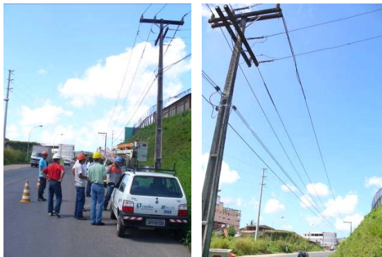
Figura 14 – As fotos mostram o vão de 100 m da rede de distribuição da COELBA, onde se realizou a substituição dos cabos de energia em linha viva, durante a inspeção inicial das estruturas e estabelecimento do procedimento a ser adotado.
