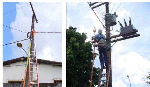
Figura 07: À esquerda, pode ser visto o lançamento da carretilha de solo, com vara de manobra telescópica. À direita, pode-se visualizar o lançamento da carretilha com o bastão pega-tudo, com o electricista utilizando uma escada ou, eventualmente, escalando o poste.
