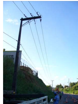
Figura 23: Vista da rede de distribuição, após conclusão da substituição dos cabos, com a rede energizada.
