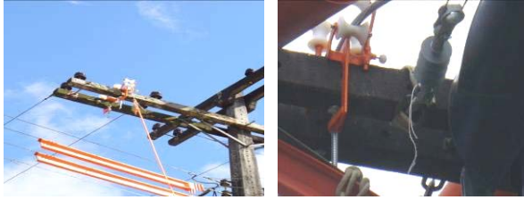
Figura 09: À esquerda, pode-se observar a funcionalidade da carretilha durante o lançamento da corda-guia e corda de tração. À direita, observa-se a carretilha com o cabo novo sendo tracionando e ao mesmo tempo realizando a função de isolamento temporário do cabo em relação à cruzeta.
