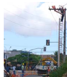
Figura 16: Lançamento da corda-guia e corda de tração.
