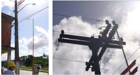
Figura 10: A foto da esquerda mostra a ferramenta de lançamento da corda-guia, do solo, por meio de vara de manobra telescópica. A foto da direita mostra a passagem da corda-guia e sua liberação sobre a carretilha.
