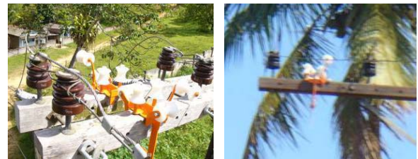
Figura 02: A fotografia da esquerda mostra a aplicação correta das carretilhas em uma estrutura com duas cruzetas. A fotografia da direita mostra a aplicação correta da carretilha sobre uma estrutura com uma única cruzeta.
