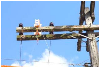
Figura 11: Passagem da corda-guia sobre a carretilha, com o rolete de travamento acionado.
