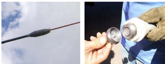
Figura 05: Na figura pode-se visualizar o dispositivo de acoplamento corda isolada cabo. A ferramenta possui isolamento elétrico compatível e é confeccionada em nylon. Na foto à esquerda, a ferramenta é aplicada em lançamento de cabos protegidos de 185 mm. A foto da direita mostra o dispositivo interno do sistema que permite o aprisionamento do cabo elétrico.
