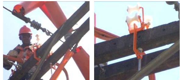
Figura 15: Lançamento das carretilhas nas estruturas pelas equipes de linha viva.
