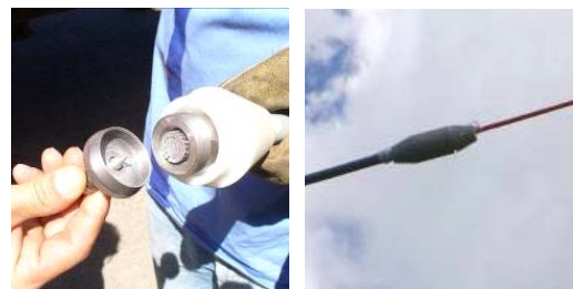
Figura 17: À esquerda, é mostrada a realização do aprisionamento do cabo novo no sistema de acoplamento cabo-corda. À direita, pode-se visualizar o tracionamento do conjunto corda isolante e cabo novo.
