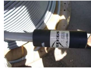
Figura 06: Mufla isolante acoplada à terminação de cabo protegido de 185 mm. O carretel permanece em solo e a mufla garante o isolamento da terminação metálica do cabo, aumentando a segurança do procedimento.
