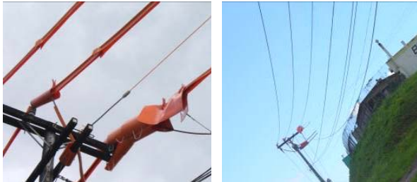
Figura 19: À esquerda, pode-se observar a passagem do cabo pela segunda estrutura. À direita, observa-se o cabo completamente lançado no trecho da rede em manutenção.
