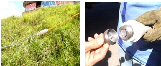
Figura 12: À esquerda é mostrado a sistema de acoplamento cabo corda sendo usado na tração de um cabo protegido de 185 mm, durante a atividade de lançamento de cabos. À direita, pode-se visualizar o sistema interno do acoplamento cabo-corda para o aprisionamento do cabo novo, garantindo a sua não liberação durante o processo de tração.
