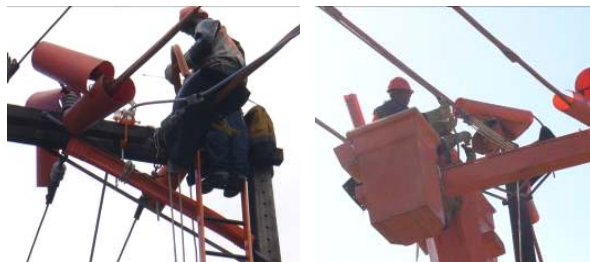
Figura 20: Equipes de linha viva realizando o encabeçamento do cabo novo nas extremidades da rede de distribuição.
