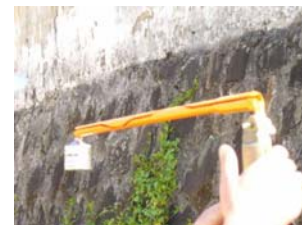
Figura 03: A fotografia mostra o equipamento lançador de corda guia. A ranhura lateral vista na ferramenta tem a funcionalidade de passar a corda guia e soltá-la após o lançamento. Na ponta da ferramenta pode-se visualizar o peso que aplicará a força para puxar a corda guia em direção ao solo.
