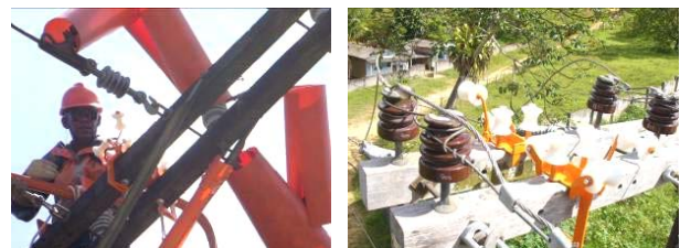
Figura 08: À esquerda, pode-se visualizar o lançamento da carretilha pelo electricista de linha viva, diretamente sobre a cruzeta. À direita, é mostrada a carretilha completa e a simples aplicadas sobre uma estrutura com duas cruzetas, prontas para receber o lançamento da corda-guia.
