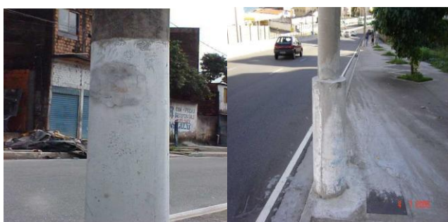
Fig. 5 – Poste com reforço de concreto
