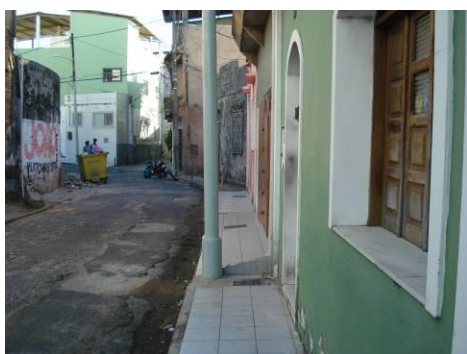
Fig. 9 – Poste tubular de aço com base recuperada
