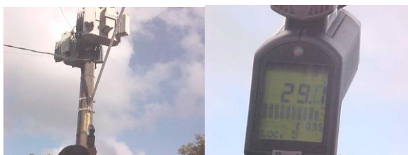
Fig. 1 – Inspeção de Transformadores com Pirômetro
