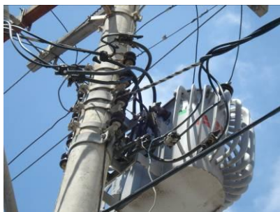
Fig. 12 - Transformador com cabo de saída para dois lados
