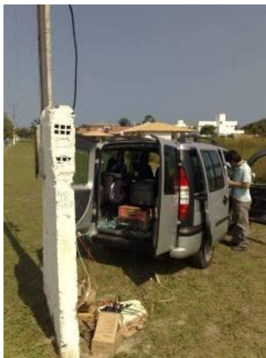
FIGURA 4 – MEDIÇÃO DOS TRANSITÓRIOS NA REDE DE BAIXA TENSÃO (POSTO 3)
