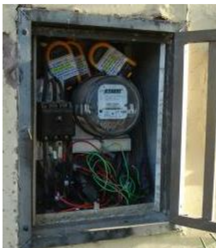
FIGURA 8 – DETALHE DA INSTALAÇÃO DOS REGISTRADORES NA REDE DE DISTRIBUIÇÃO
