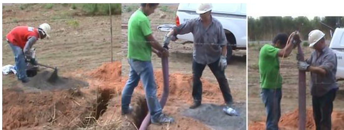
Figura 6: Enchendo e compactando caníster.
