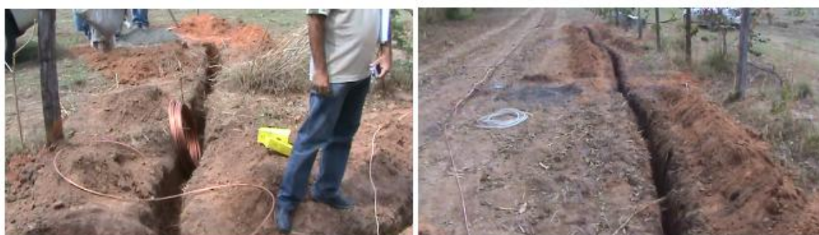
Figura 7: Vista geral dos trabalhos de escavações, e cabo de cobre de 50 mm 2 .
