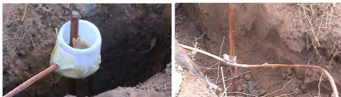
Figura 8: Solda exotérmica e isolamento da região com massa epóxi.
