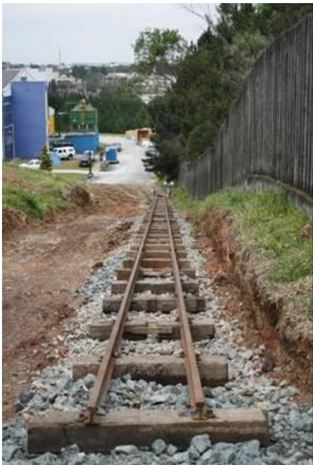
Figura 5. Local produzido para a realização do ensaio de “crash-test”.
