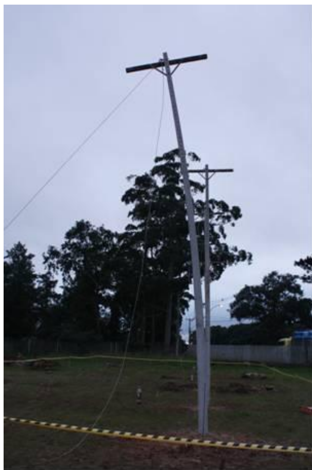
Figura 6. Figura ilustrativa do sistema forçado de deformação da estrutura em concreto, poste tipo duplo T, em solo encharcado.
