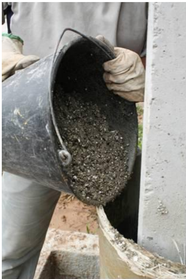
Figura 4. Preenchimento do sistema anti-impacto com material compósito.
