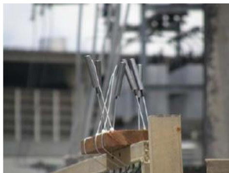
FIGURA 2. SUBESTAÇÃO LDF CUPONS DE AÇO CARBONO
