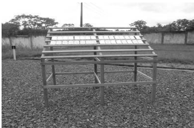
Figura 4. Painel de Intemperismo Natural da Subestação de Camaçari-BA.
