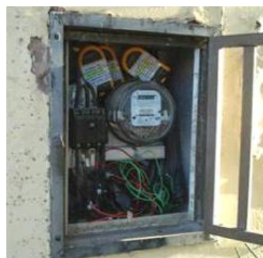
Figura 8 – Instalação dos Registradores na Rede de Distribuição
