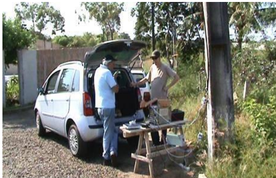
Figura 3 – Medição nas Redes de Média e Baixa Tensão (Posto 1)
